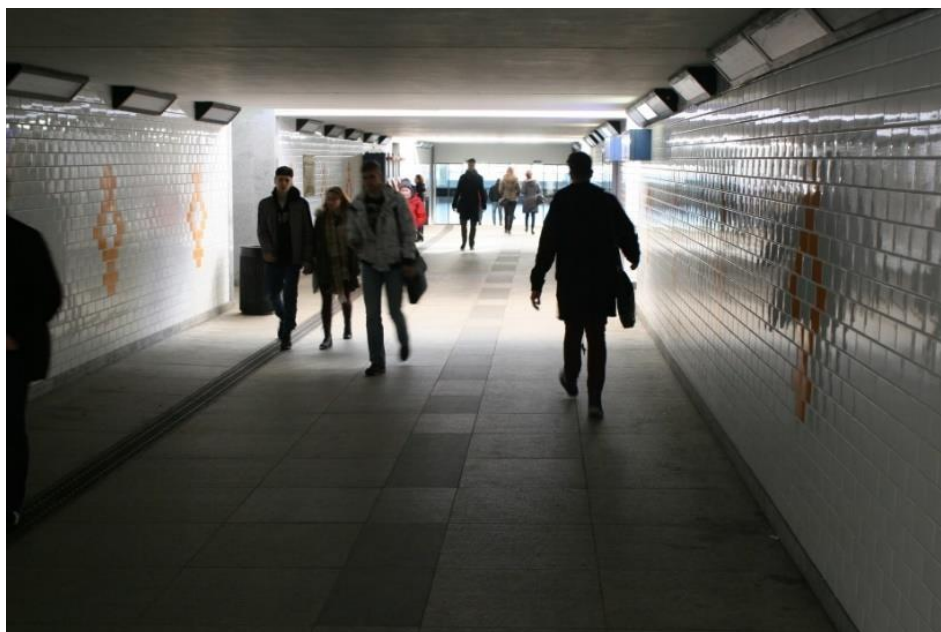
Ryc. 5.2. Tunel peronowy w Sopocie z właściwą lokalizacją oświetlenia górnego (autor: D. Załuski)
