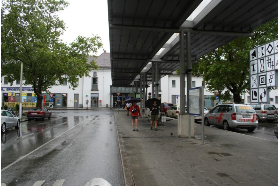
Ryc. 4.3. Poprawnie zaprojektowane zadaszenie, chroniące podróżnych na całym odcinku pomiędzy wyjściem z budynku dworca w Krems an der Donau (Austria) a peronami komunikacji miejskiej (autor: D. Załuski)
