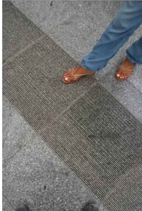
Ryc. 5.15. Całkowicie niewidoczny i niewyczuwalny system FON w strefie zabytkowej na dworcu Dresden Hbf (autor: D. Załuski)
