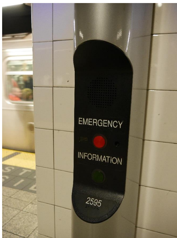
Ryc. 5.89–5.90.. Słupki informacyjno-alarmowe zaprojektowane zgodnie z zasadami projektowania uniwersalnego. Stacja metra w Nowym Jorku (autor: M. Wysocki)
