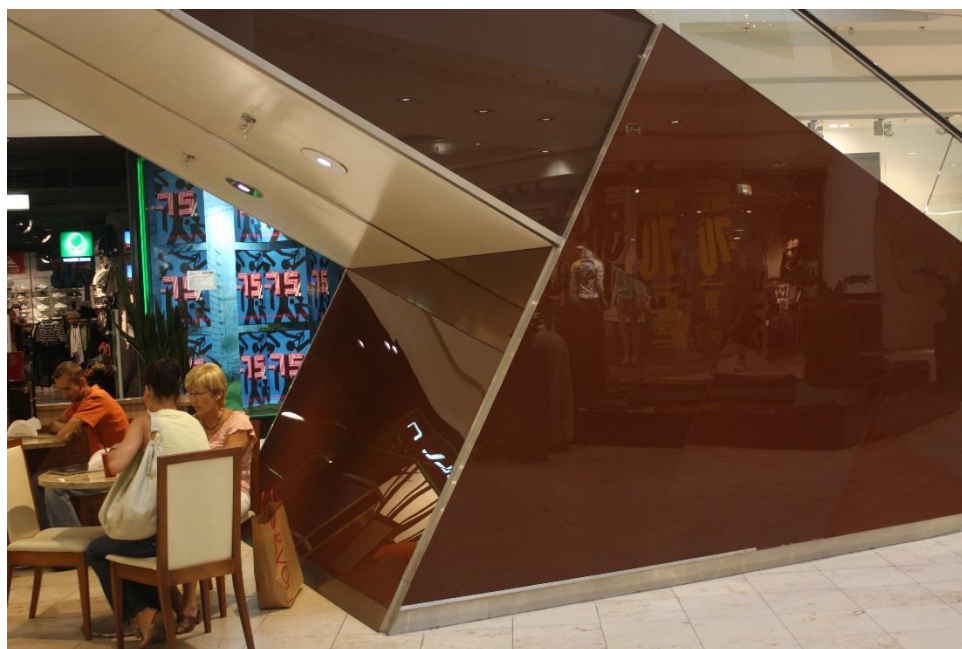
Ryc. 5.46. Prawidłowo zabezpieczona przestrzeń pod schodami poprzez zabudowę strefy niebezpiecznej dla osoby niewidomej poruszającej się przy pomocy laski (autor: M. Wysocki)
