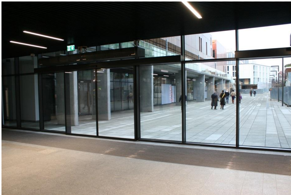
Ryc. 5.66. Źle zaprojektowane drzwi do dworca w Sopocie, trudna do zlokalizowania strefa wejścia. Tafla szklana pozbawiona oznakowania (autor: D. Załuski)
