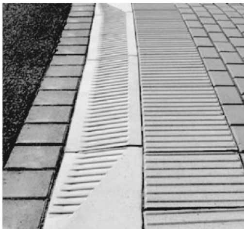
Ryc. 5.27. Specjalne karbowane wykończenie obniżenia krawężnika ułatwiające osobom niewidomym odczytanie laską krawędzi chodnika (źródło: www.asmat-grosshandel.com ).
