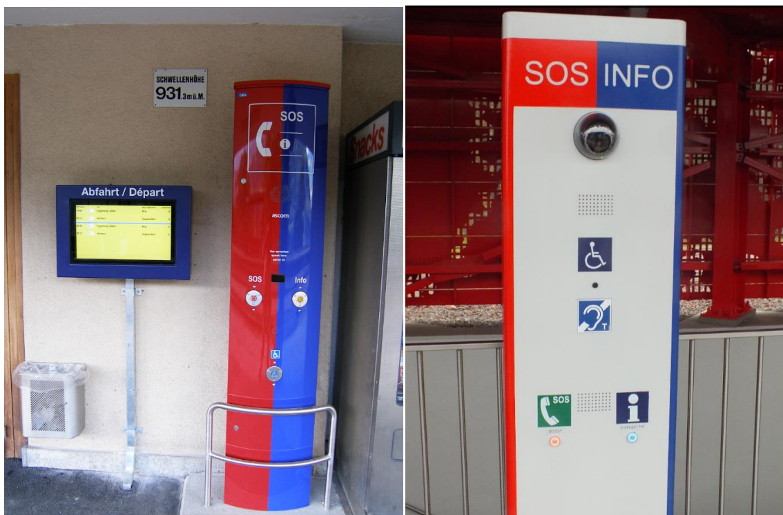
Ryc. 5.87, 5.88. Słupki informacyjno-alarmowe na górskiej stacji kolei BLS (Szwajcaria) i Gdańsk Brętowo (PKM SA). Oba przypadki są dobrze opisane alfabetem Braille’a, a ich kolorystyka dobrana została kontrastowo do tła (autor: P. Wróblewski).
