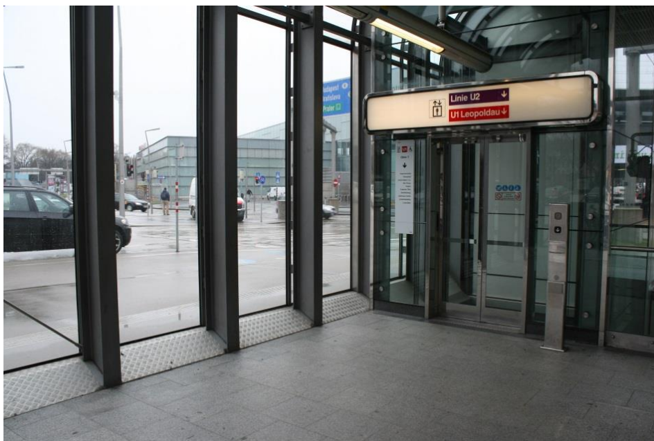
Ryc. 5.68. Żle zaprojektowane, pozbawione oznakowań ściany szklane na dworcu Paterstern Wien. (autor: D. Załuski)
