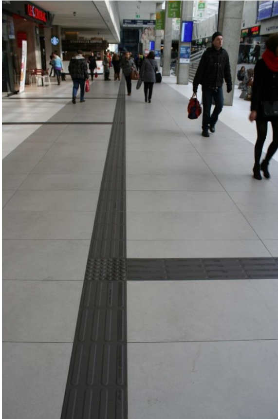
Ryc. 5.14. System FON na dworcu Katowice. Zastosowano zbyt małe powierzchnie pól uwagi w punktach decyzyjnych zmiany kierunków. Dobry kontrast barwny (autor: D. Załuski)
