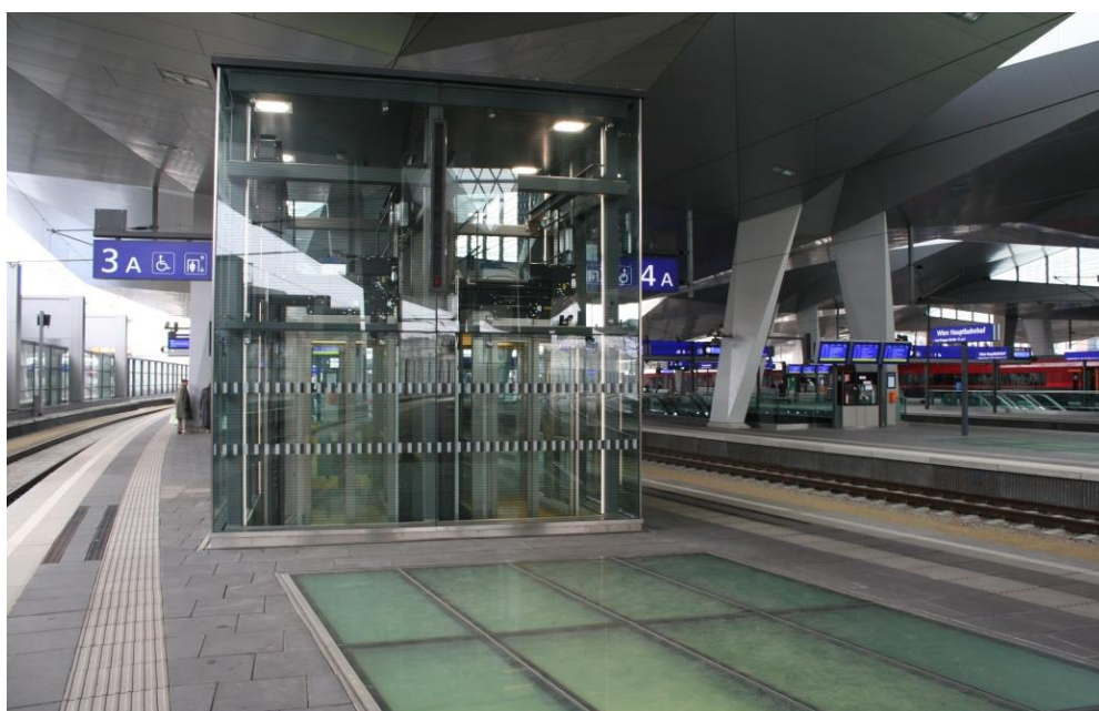
Ryc. 5.5. Błędnie zaprojektowana szklana podłoga doświetlająca tunel peronowy, zamieniająca się w wilgotne dni w lodowisko – dworzec Wien Hbf (autor: D. Załuski)
