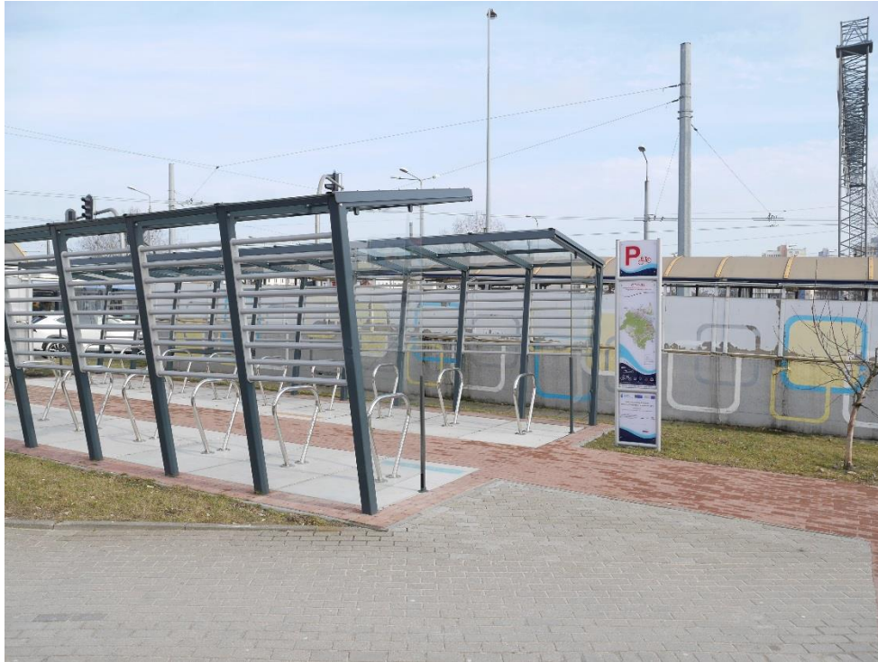
Ryc. 5.105. Stojaki rowerowe pod zadaszeniem. Stacja SKM Gdynia Orłowo (autor: M. Wysocki)
