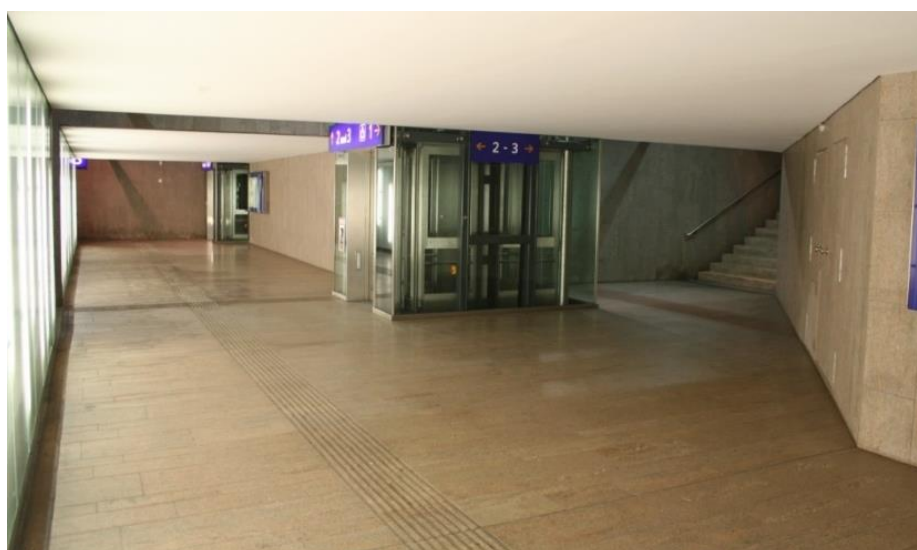
Ryc. 5.3. Tunel peronowy na dworcu Leoben Hbf (Austria) ze złym oświetleniem bocznym przejścia – piesi przy oświetleniu będą zaciemniać przejście dla innych użytkowników; właściwie ścięte narożniki dojsć do schodów na perony intuicyjnie wskazujące kierunek ruchu; windy usytuowane w martwym polu tunelu, jednoznacznie widoczne z dojścia (autor: D. Załuski)
