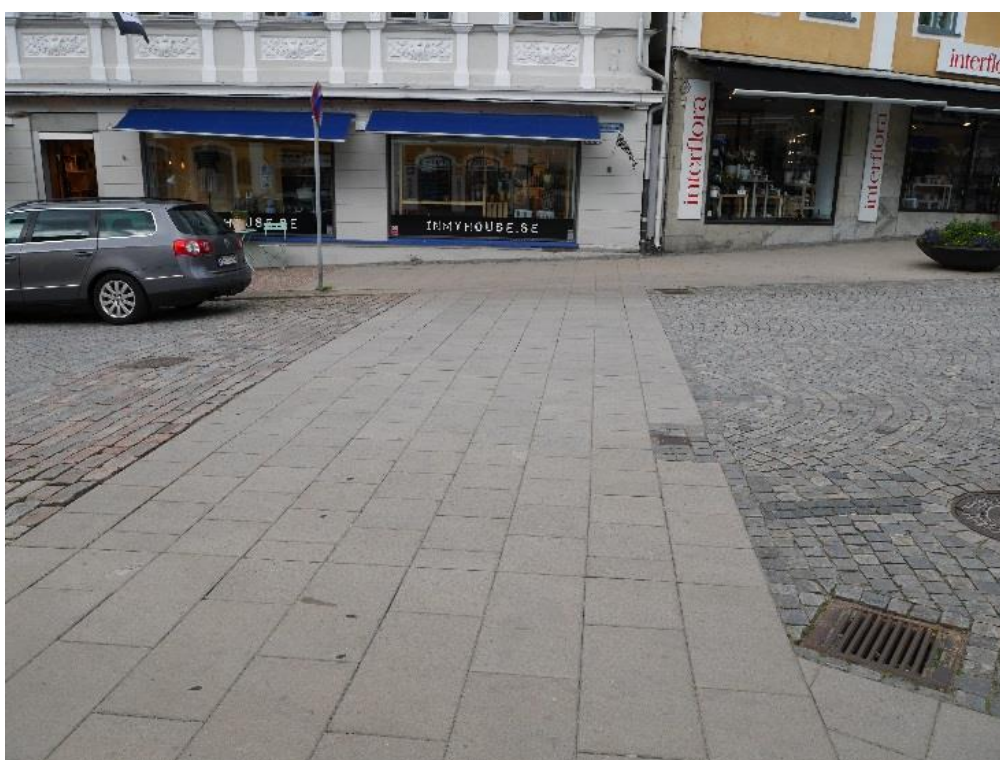
Ryc. 5.35. Chodnik przejezdny zapewnia trasę wolną od przeszkód, Karlskrona (Szwecja), (autor: M. Wysocki)
