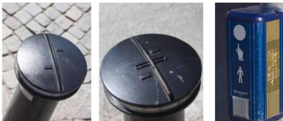
Ryc. 5.31, 5.32, 5.33. Schematy dotykowe przejścia dla pieszych mogą ułatwić wytyczenie kierunku przechodzenia przez jezdnię. Mogą być montowane na osobnych słupkach lub przyciskach uruchamiających sygnalizację. Schematy przejść: 5.31: bez wysepki, 5.32 i 5.33: z wydzieloną wysepką (autor: M. Wysocki)
