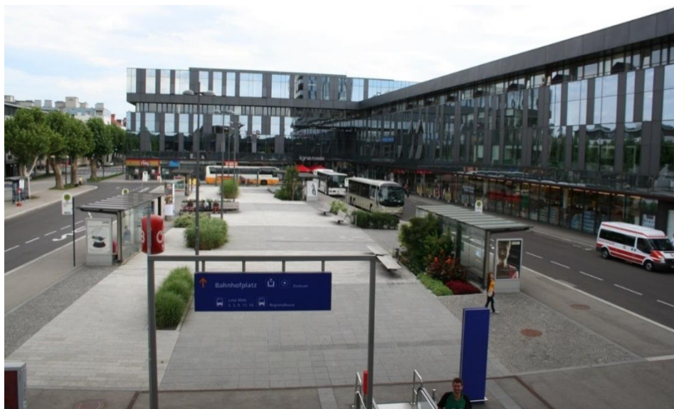
Ryc. 5.115. Wyspa z przystankami autobusowymi przez zejściem głównym z dworca w Wels (Austria) (autor: D. Załuski)
