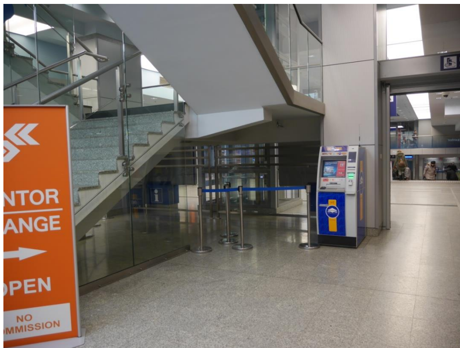
Ryc. 5.47. Źle zaprojektowana przestrzeń pod schodami, trudna do zachowania czystości i ulubiona przez bezdomnych. Przestrzeń wtórnie ogrodzona słupkami, które nie stanowią zabezpieczenia przed niekontrolowanym wejściem osoby z niepełnosprawnością wzroku – dworzec Kraków Główny (autor: M. Wysocki)
