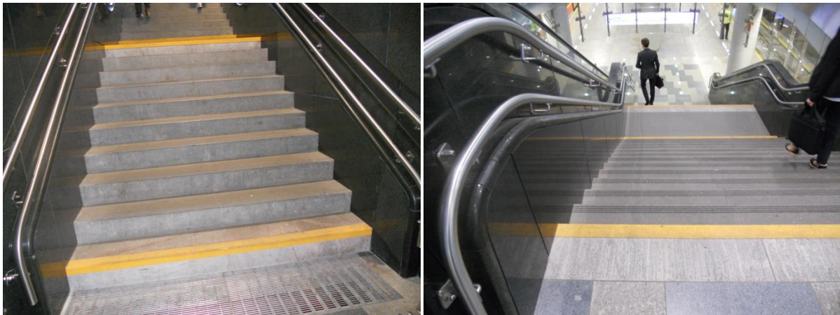
Ryc. 5.40. 5.41. Prawidłowo oznaczone krawędzie pierwszego i ostatniego stopnia biegu schodowego. Stacja II linii metra w Warszawie – Dworzec Wileński. (autor: M. Wysocki)
