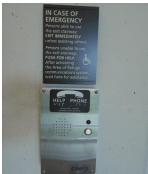
Ryc. 5.132. Intercom w pomieszczeniu oczekiwania zapewnia dwukierunkową łączność z ekipami ratowniczymi (autor: M. Wysocki)
