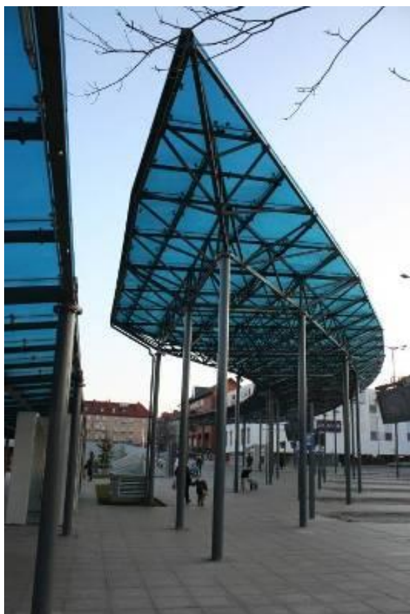
Ryc. 5.120. Dworzec autobusowo-kolejowy w Tczewie z dobrze zaprojektowanym, bezkolizyjnym przejściem pieszym do zatok autobusowych (autor: D. Załuski)
