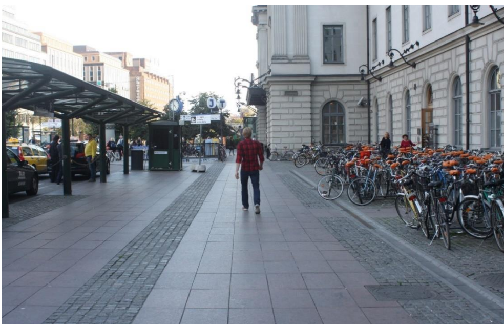
Ryc. 5.8. Zmiany faktur nawierzchni chodników przy stacji Sztokholm Główny (Szwecja) wyznaczają linie kierunkowe poruszania się osób z niepełnosprawnością wzroku (autor: M. Wysocki)
