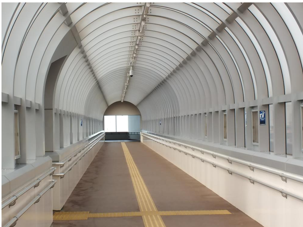
Ryc. 5.82. Przykład ścieżki dotykowej prowadzącej na perony i dodatkowych poręczy, mimo trasy poziomej, w miejscowości uzdrowskiej Toya, Japonia (Autor: P. Wróblewski)
