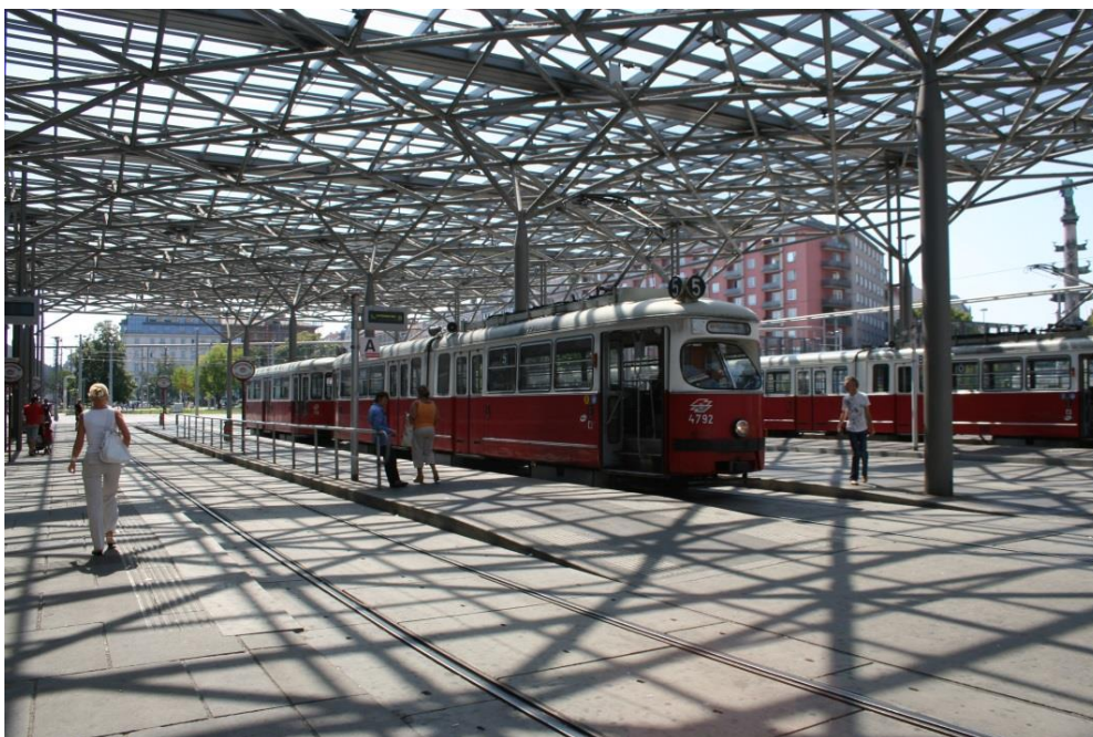
Ryc. 4.1. Przykład źle zaprojektowanego zadaszenia, które daje mylne cienie na nawierzchnię przystanków na dworcu Paternstern Wien, dezorientujące pasażerów i kierowców; szare nawierzchnie ciągów pieszych i jezdni zlewają się w jedną niebezpieczną przestrzeń (autor: D. Załuski)
