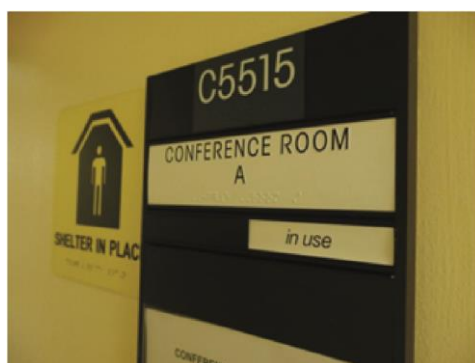
Ryc. 5.134. Miejsce oczekiwania na ewakuację powinny być zorganizowane w pomieszczeniu o podwyższonej odporności ogniowej i odpowiednio oznakowane (autor: M. Wysocki)
