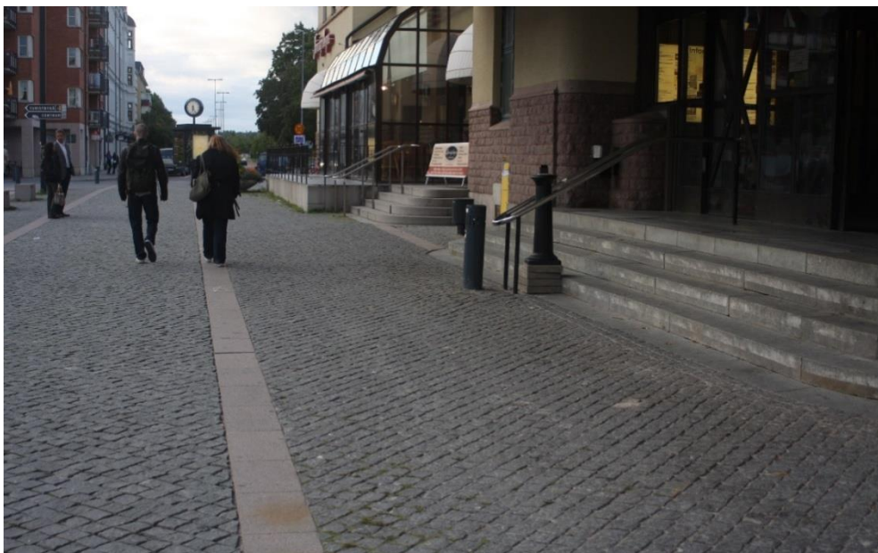
Ryc. 5.7. Zmiany faktur przy stacji Gävle, choć są czytelne dla osób z niepełnosprawnością wzroku, to w tym przypadku zbyt wąskie i niewygodne dla osób z ograniczoną mobilnością (poruszających się na wózkach lub o kulach) (Szwecja) (autor: M. Wysocki)
