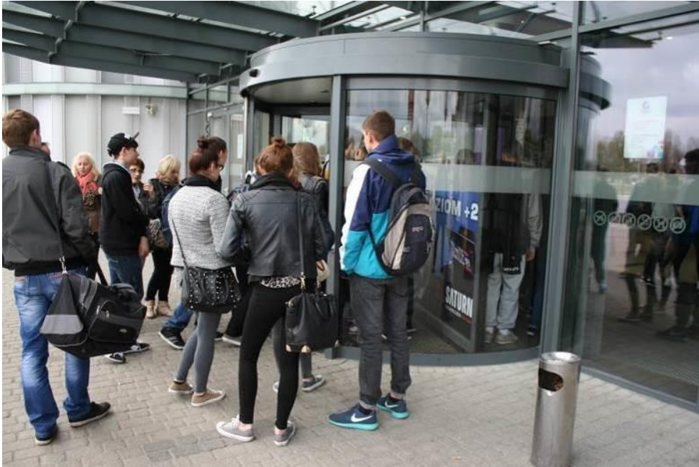
Ryc. 5.67. Źle zaprojektowane drzwi obrotowe, o zbyt małej przepustowości – dworzec Poznań Główny (autor: D. Załuski)
