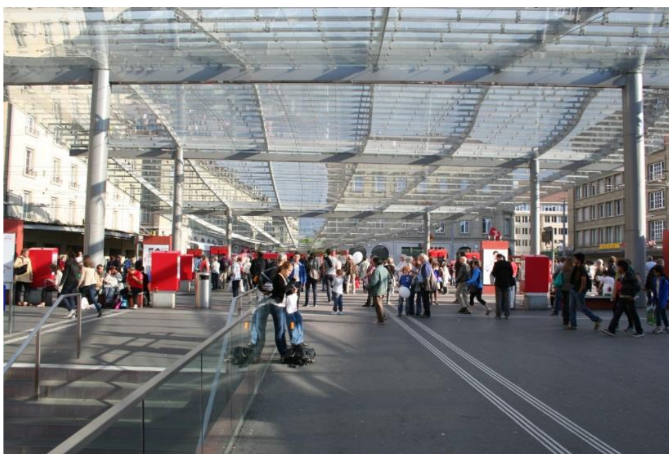
Ryc. 4.2. Dobrze zaprojektowane, szklane zadaszenie, niedające mylnych cieni na nawierzchnię ciągów pieszych i przystanków przy dworcu Bern Hbf (autor: D. Załuski)
