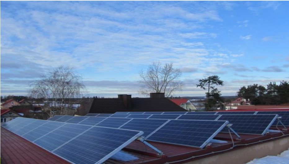
Panele fotowoltaiczne na dachach szkół w gminie Czarna Dąbrówka - 58 paneli o łącznej mocy 14,5 kW
